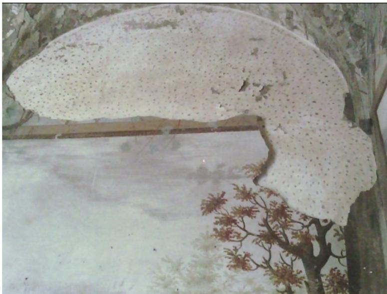
Mappatura dello stato di distacco dell'intonaco storico dall'apparato murario
